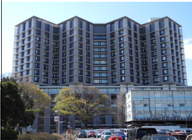
写真1：写真の工事現場のプレハブ部分に、 臨床研究棟が建設されます。
